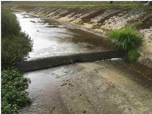
Ecrêtement des seuils béton Découpe d'échancrure et recharge aval
