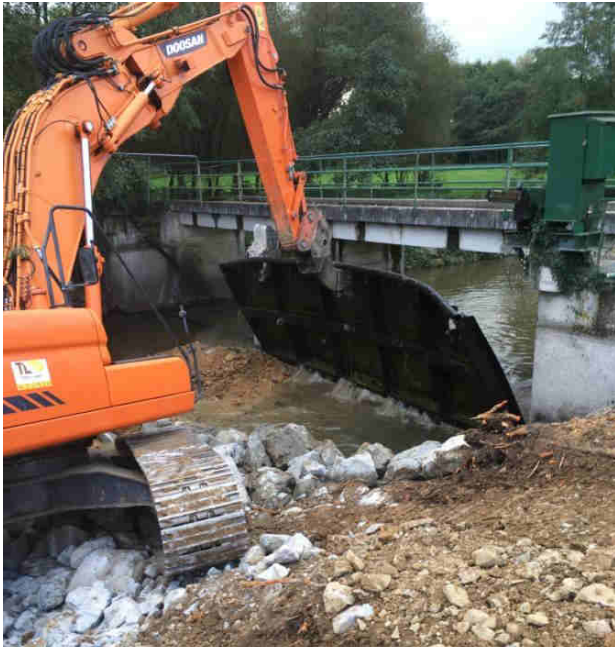
Suppression du barrage
