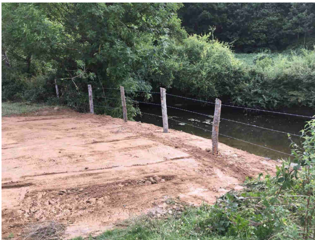
Suppression d'abreuvoir en berge
