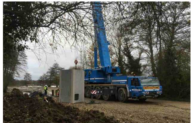
Installation du poste de pompage
