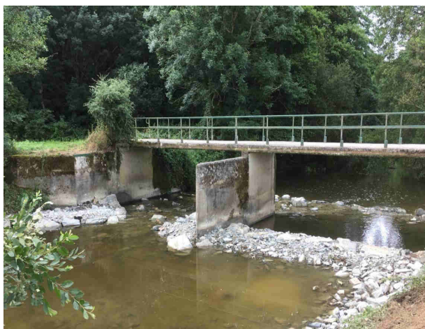
Suppression de l'ouvrage Recharge du radier
