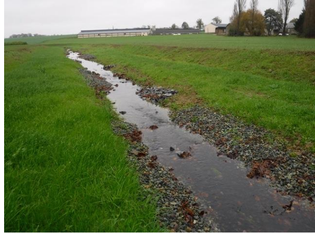
Travaux de remodelage du ruisseau du Prieuré
