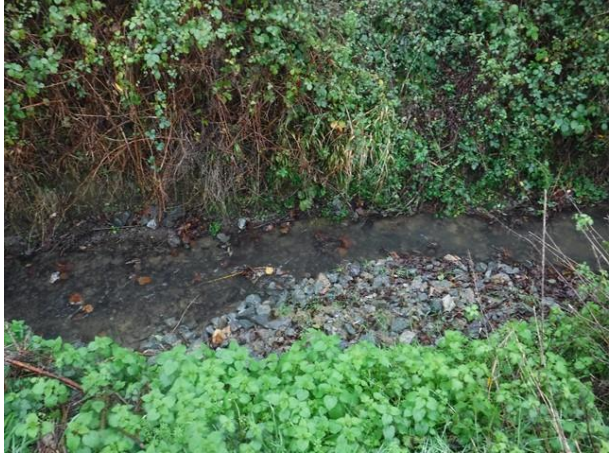
Recharge en granulats sur le ruisseau du Prieuré
