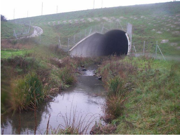
Pont de la LGV au niveau de l'Ouette à Bazougers
