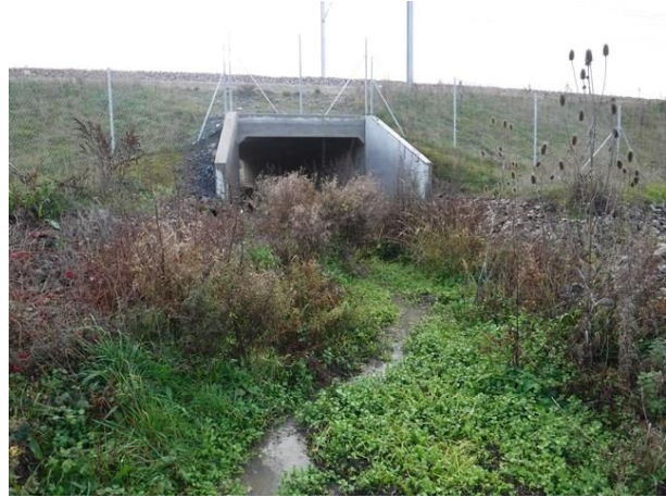
La LGV coupant le ruisseau des Attelées à Bazougers
