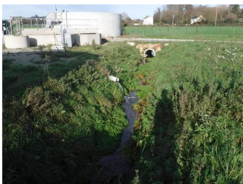
Rejet de station d'épuration sur l'Aunay
