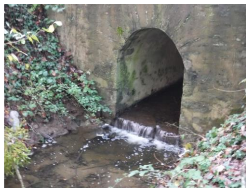
Radier de pont impactant pour la continuité piscicole et sédimentaire sur le ruisseau des Attelés
