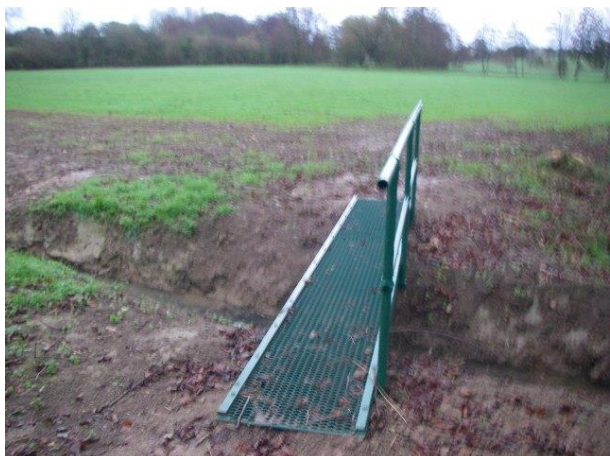
Passerelle au niveau de la connexion avec l'Ouettes et la nouvelle frayère
