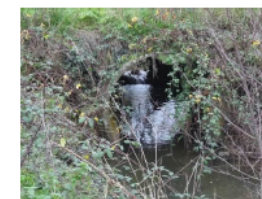
Figure 5 : Ouvrage existant (source : SETEC, 2014)
