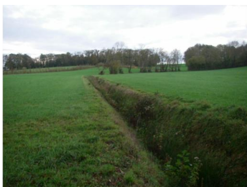
Rectification et recalibrage des berges sur le ruisseau du Chênay
