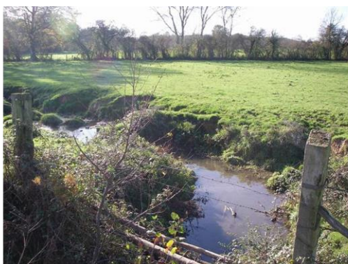
Le piétinement intensif dégrade et érode les berges, sur l'Olette
