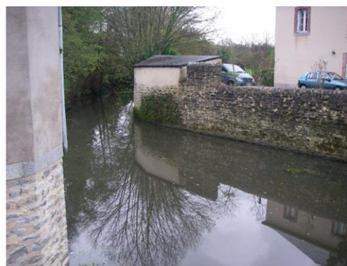
Protection de berges en génie civil sur l'Ouette à Parné-sur-Roc
