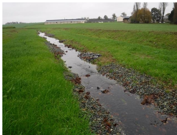
Travaux de remodelage du ruisseau du Prieuré
