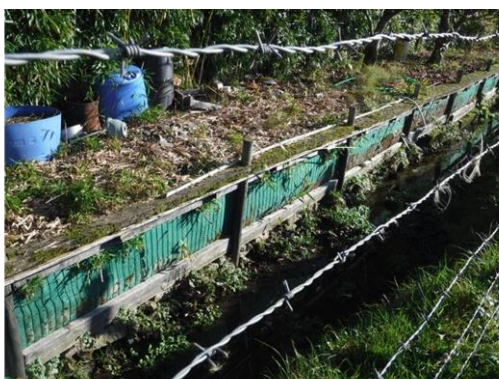
Protection de berge artisanale sur l'amont de l'Aunay
