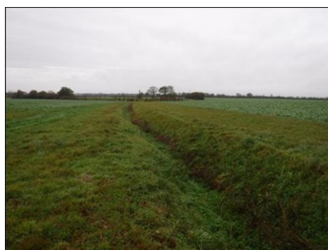
Lit recalibré et rectifié Ruisseau de la Babouessière
