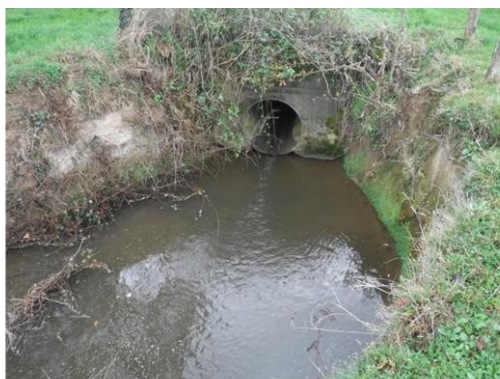
Passage busé impactant sur le ruisseau des Cormier
