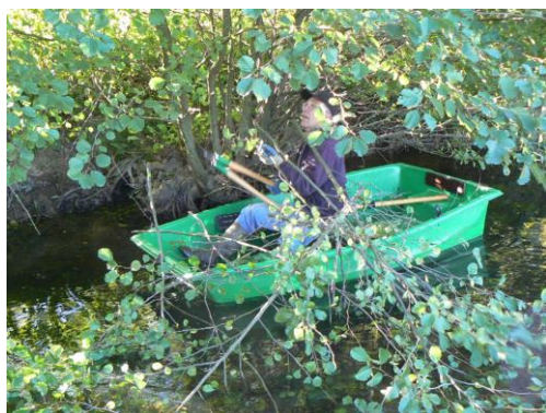
Nettoyage et entretien d'un cours d'eau
