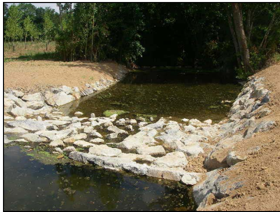
Rampe et mini-seuil en aval
