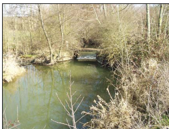
Ancien batardeau et bras de décharge
