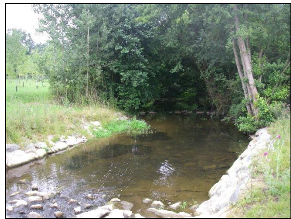
Vue aval du seuil en 2011
