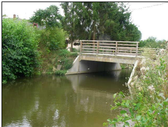
Vue amont pont 2009
