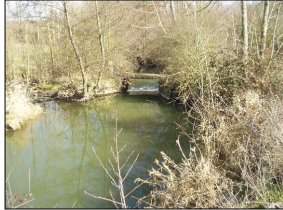
Ancien batardeau et bras de décharge
