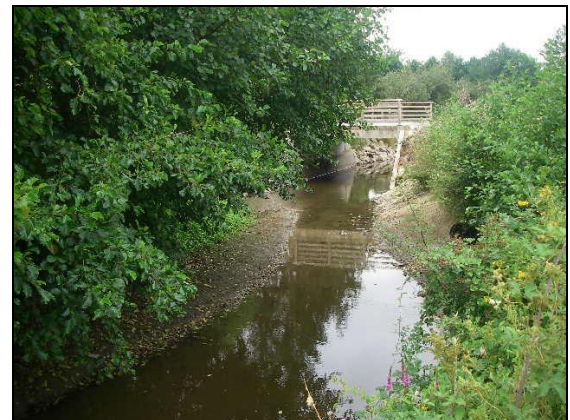
Vue amont pont 2010
