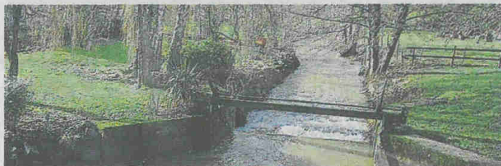
L'ouvrage de la Saugère dont le clapet fera l'objet de travaux de restauration.
