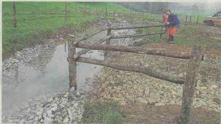
La mise place d'abreuvoirs et de radiers sur le ruisseau d'Ambricis.
