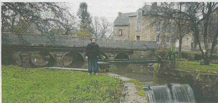
Le technicien du syndicat de bassin Xavier Seigneuret devant le barrage de Saugere, l'un des onze ouvrages concernés par le nouveau programme.
